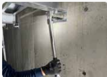
各種ボルト締め付けトルク確認
