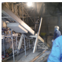
既存装置解体作業
