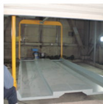
新規装置部材設置作業
