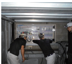
メイン制御盤交換
