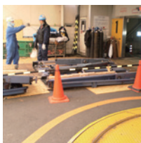
既存装置解体作業
